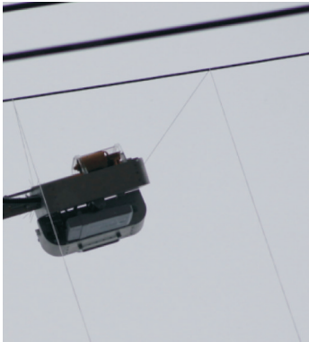
图14 无人机抛绳结合电动升降装置现场图
